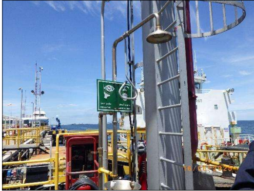
รูปที่ 2-67 การจัดเตรียมอุปกรณ์ชำระล้างฉุกเฉิน
