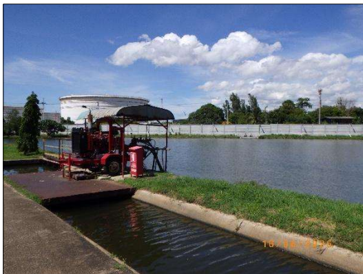
รูปที่ 2-39 ป่อสำรองน้ำดับเพลิง
