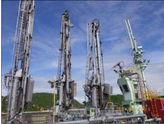
รูปที่ 2-2 ระบบ Vapor Return บริเวณท่าเทียบเรือ
