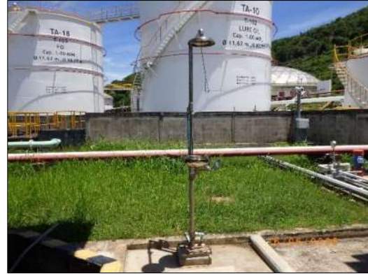
รูปที่ 2-67 การจัดเตรียมอุปกรณ์ชำระล้างฉุกเฉิน
