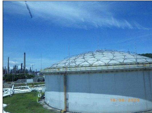
รูปที่ 2-41 ถังเก็บสำรองน้ำมันออกแบบให้มีหลังคา 2 ชั้น เพื่อลดการปล่อยไอสารอินทรีย์ (VOCs)
