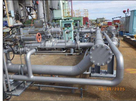
รูปที่ 2-2 ระบบ Vapor Return บริเวณท่าเทียบเรือ
