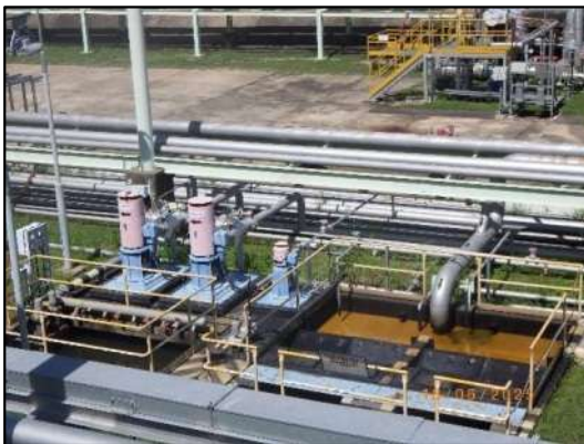
รูปที่ 2-5 ระบบบำบัดน้ำเสียของคลังก๊าซเขาบ่อยา
