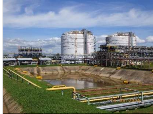
รูปที่ 2-33 ป่อกักเก็บก๊าซ กรณีผลิตภัณฑ์รั่วไหล
