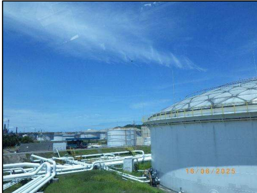
รูปที่ 2-41 ถังเก็บสำรองน้ำมันออกแบบให้มีหลังคา 2 ชั้น เพื่อลดการปล่อยไอสารอินทรีย์ (VOCs)
